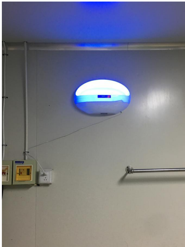
工具清洗间整改后
