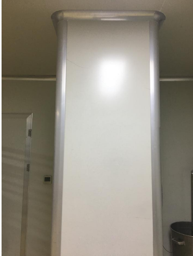
调面间整改前
