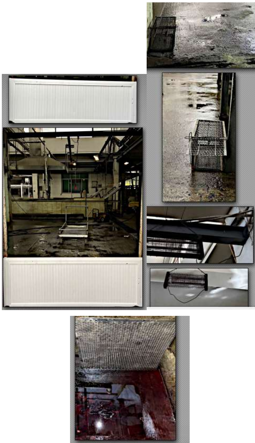
整改后，加虫鼠害防治设施（挡鼠板、防鼠网、捕鼠笼、灭蝇灯等）
