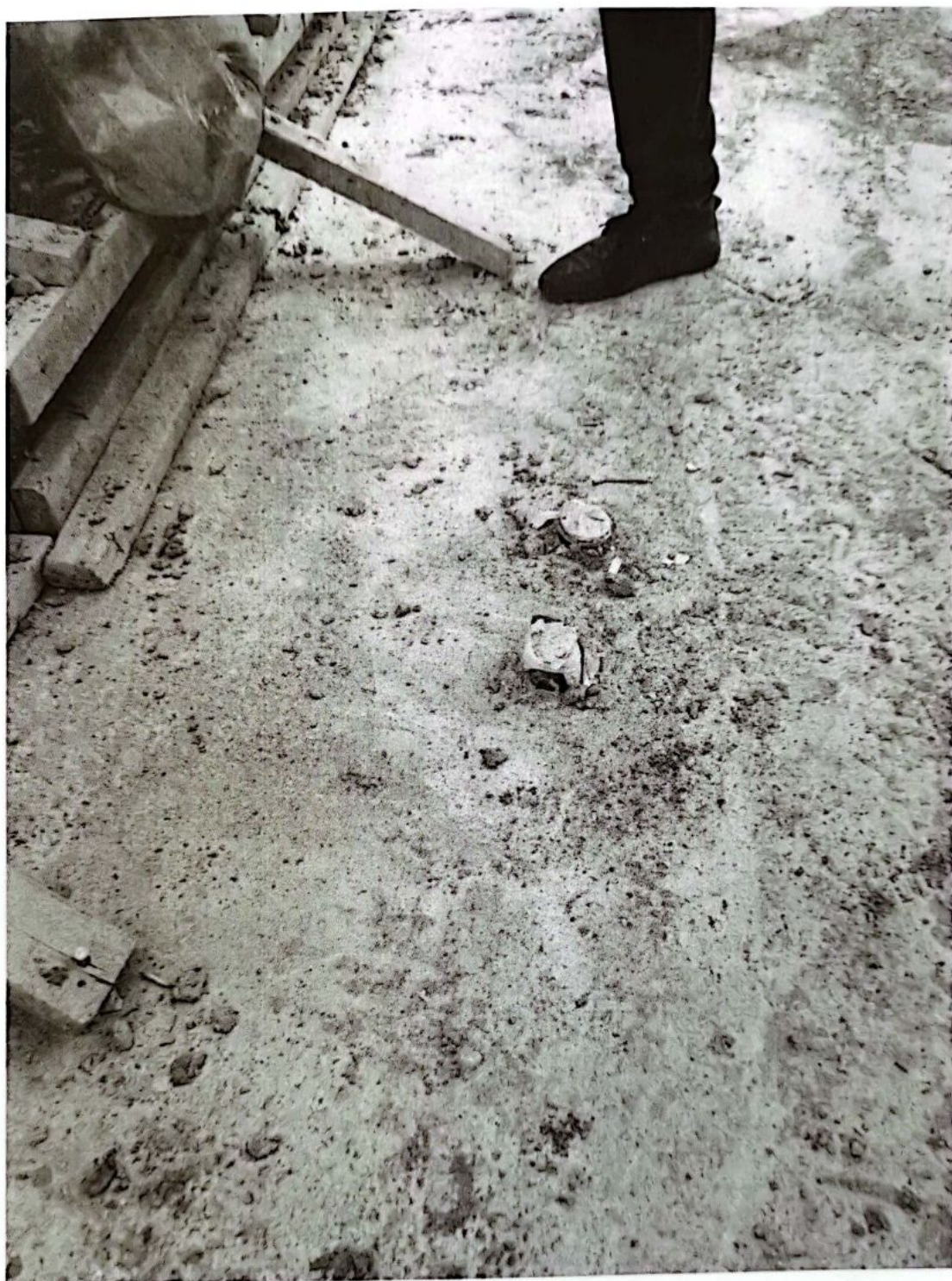
施工现场工作人员使用塑胶对管口进行临时封堵的防护措施
