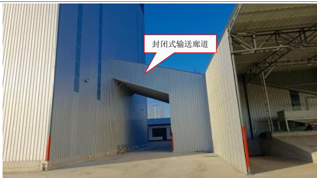
封闭式输送廊道
