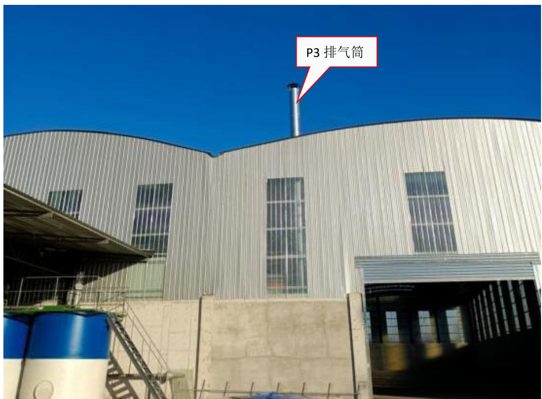
膨胀剂筒仓进料废气处理设施排气筒(P3)
