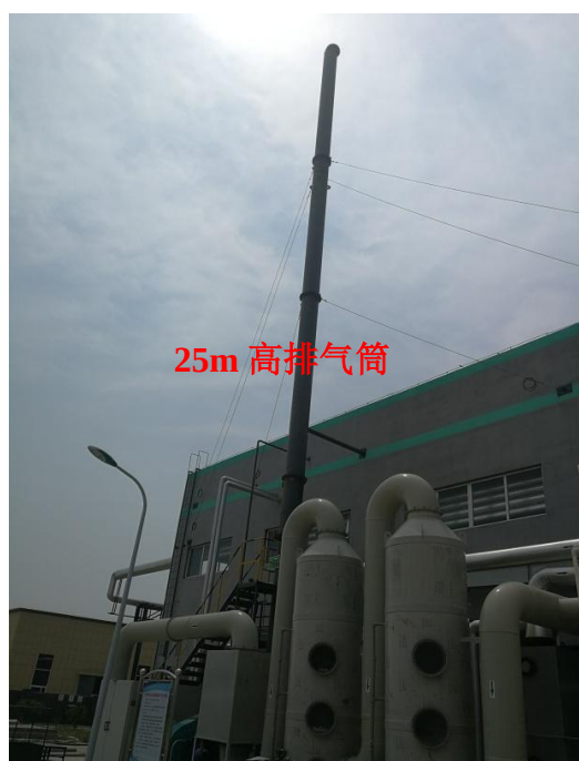
图 4.2-1 P1 排气筒废气处理措施建设情况
