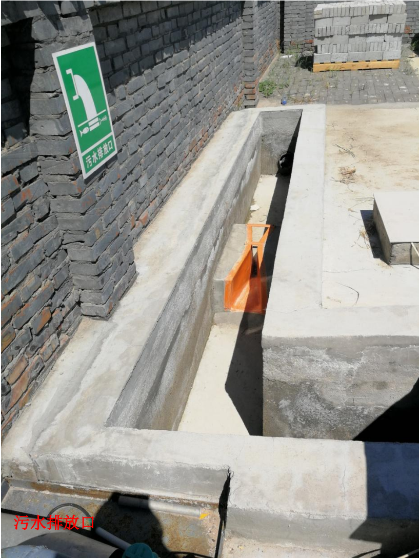
图 4.2-3 厂区污水处理站实际建设情况
