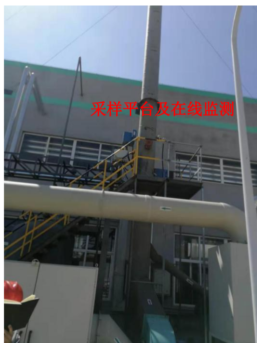
图 4.2-1 P1 排气筒废气处理措施建设情况
