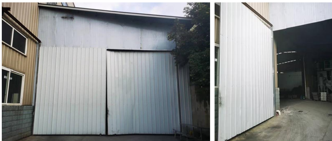
图 2-24 抛丸区西侧加装门隔声
