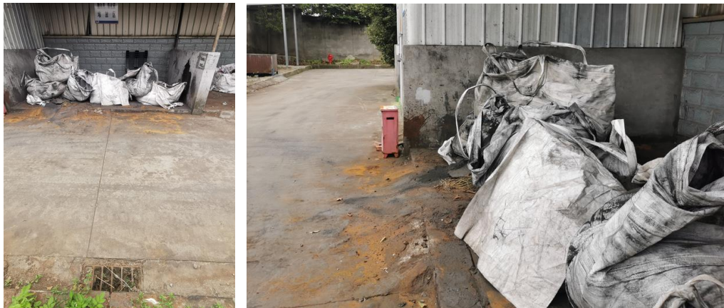
图2-29 一般固废暂存棚临雨水沟和防流失设施不完善
