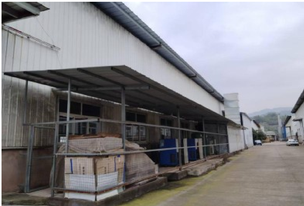
废气处理装置
