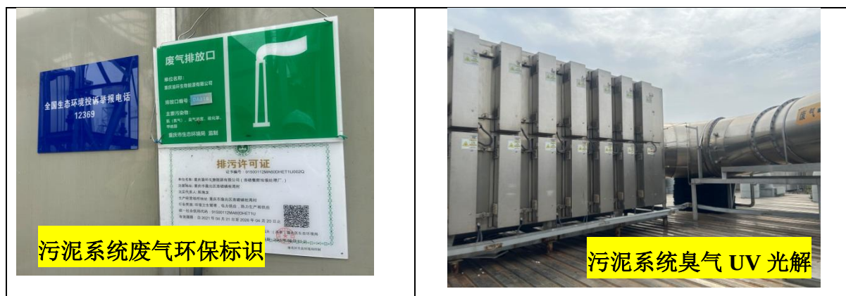
图 4.1-2 市政污泥废气系统照片
