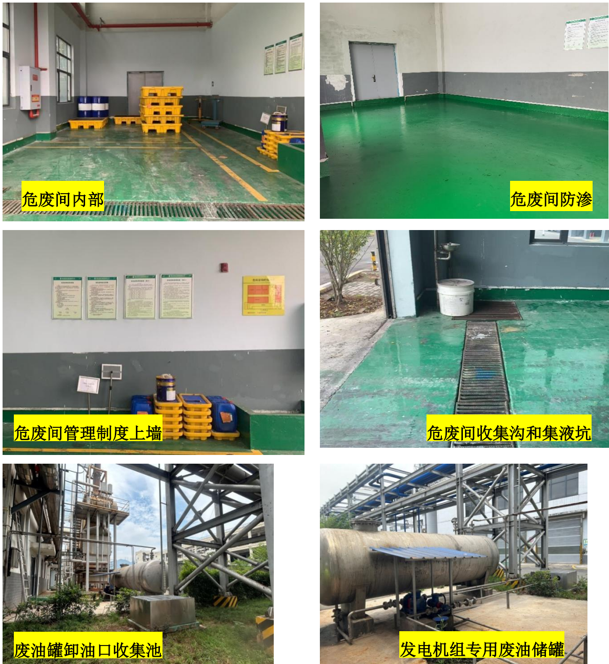
图 4.1-7 固体废物贮存设施
