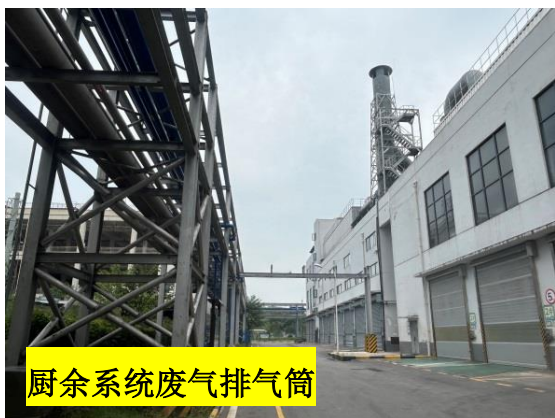
厨余系统废气收集管
