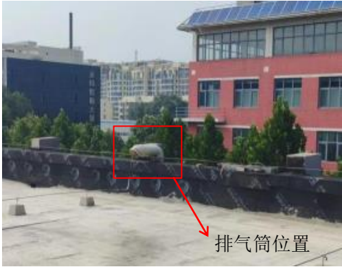
图 1 检验废气排气筒现状照片
