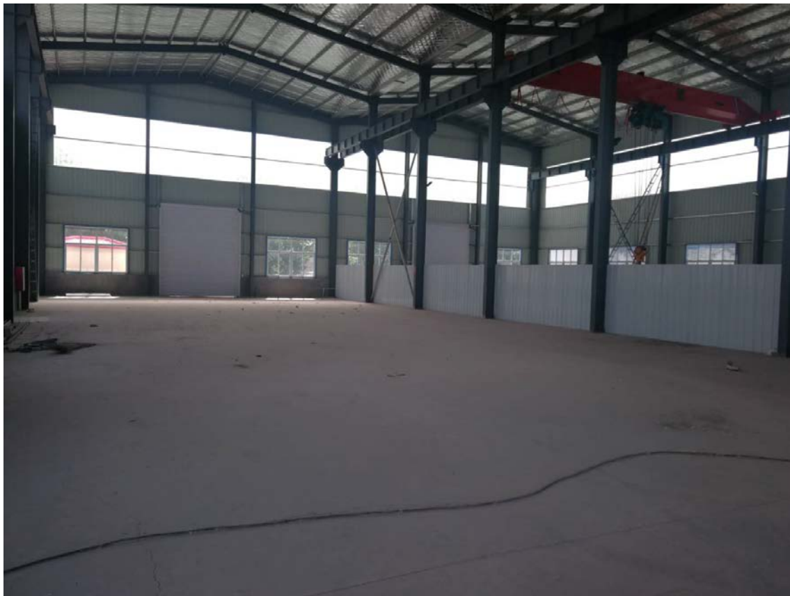
项目现场照片
