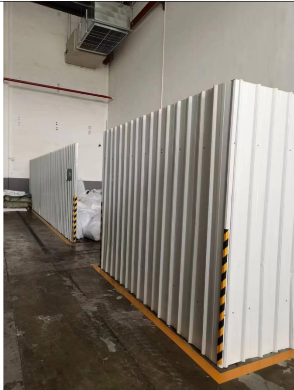
一般固废暂存库（外）
