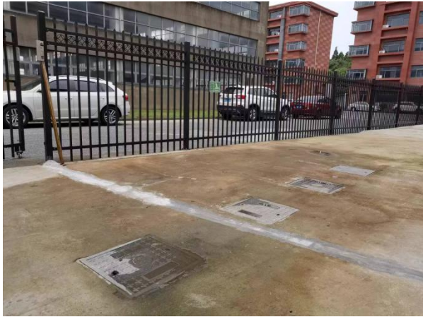
生活污水排放口
