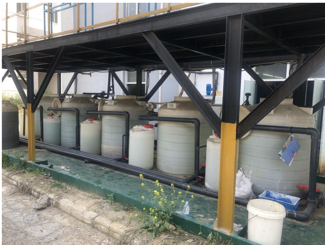
图 3.1.3-1 废水收集系统照片
