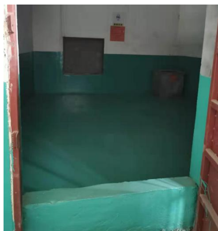
危废间防渗措施
