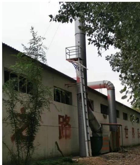
弦乐高档吉他车间南北两个喷漆房 UV 光氧+活性炭吸附装置
