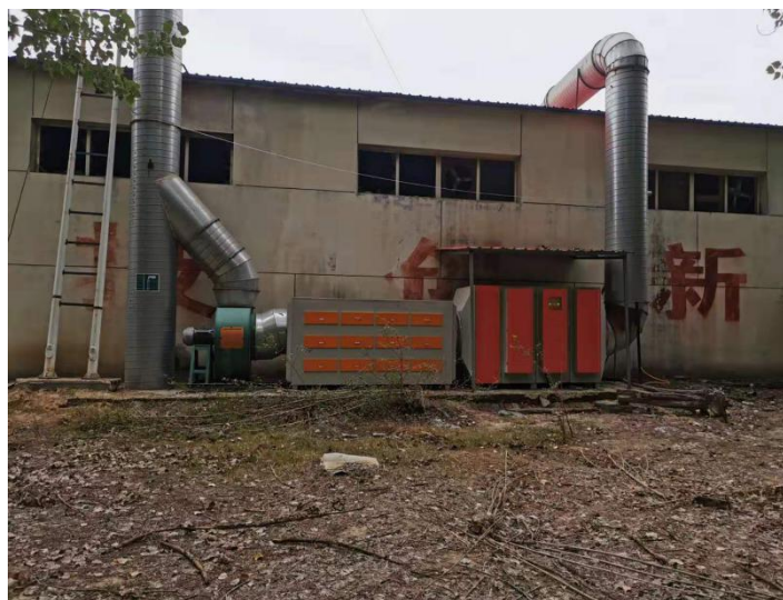
弦乐高档吉他车间南北两个喷漆房 UV 光氧+活性炭吸附装置
