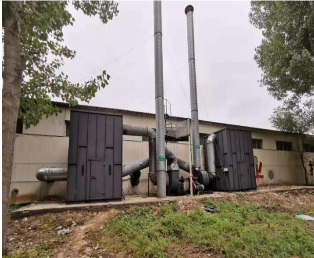
管乐车间布轮、砂轮布袋除尘器
