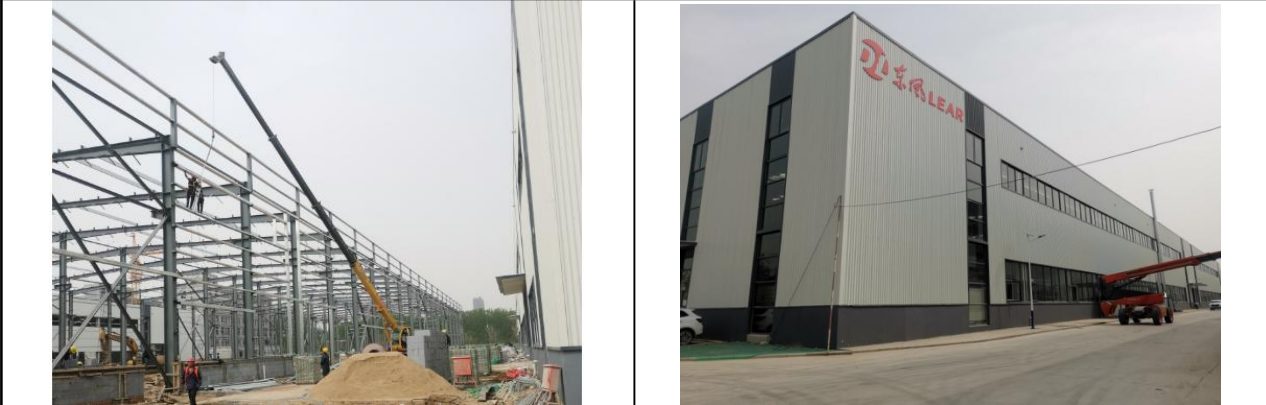
车间南边界：在建厂房
