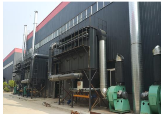
分装袋式静电脉冲除尘器及排气筒
