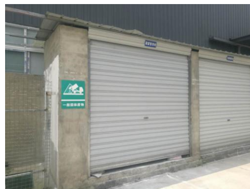
一般固废暂存间
