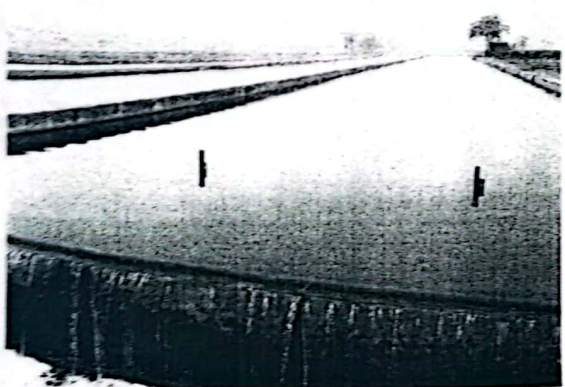
炼油厂污水处理厂缓冲池
