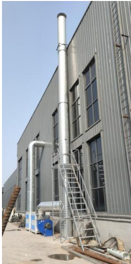
图 4-2 配料搅拌、浸胶、缠绕、固化、模压成型、糊制工序和钾肥设备生产打磨 工序排气筒
