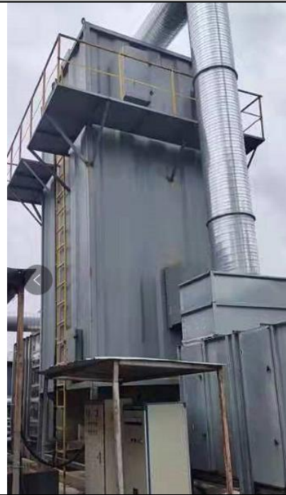
本项目现有废气处理设备：电捕焦油器+活性炭吸附
