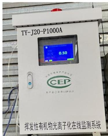
排气筒 VOCs 在线监测装置
